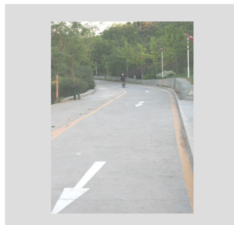
شکل ۱۰- قوس افقی دایره‌ای ساده برای ارتباط بین دو مسیر متقاطع در پیست عمومی دوچرخه سواری، بوستان بهشت مادران (منبع: نگارنده)
