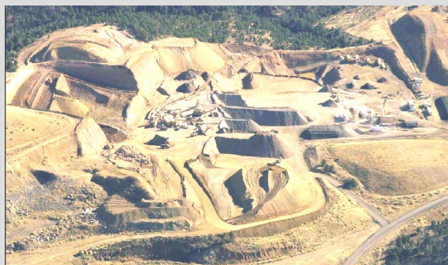
شکل ۳- طرح در حال اجرای شیب‌بندی سطح زمین (Toy and Chuse, 2005)
