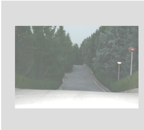
شکل ۱۶- قوس قائم مقعر در یک مسیر عبور دوچرخه، بوستان بهشت مادران (منبع: نگارنده)
