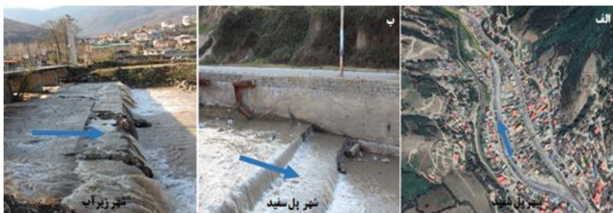
شکل ۶- نمونه‌ای از موانع پیوستگی در بازه‌های مختلف رودخانه (الف) نمای از بالای موانع پیوستگی شهر پل سفید؛ (ب) سازه عرضی (سرریز) موجود در بازه‌ی ۸؛ (ج) سازه عرضی (سرریز) موجود در بازه‌ی ۱۳ رودخانه تالار
