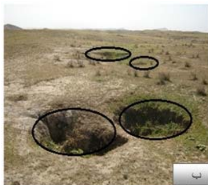
شکل ۲- الف: فروچاله‌های انحلالی و چاه‌های مکنده و ب: چاه‌های کارستی در مخزن سد جره
