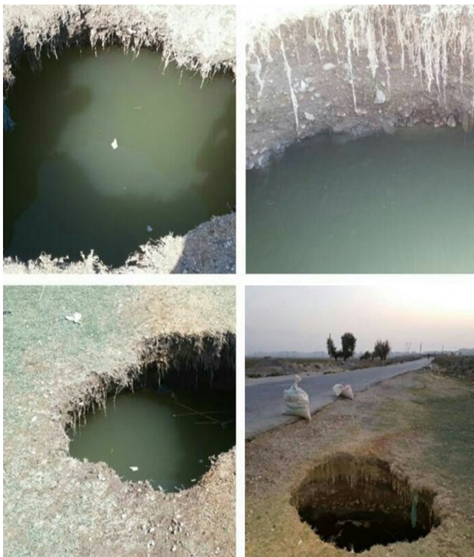
شکل ۴- فروچاله تشکیل شده در مهرماه سال ۱۳۹۶ در دشت میداوود، بین روستاهای سرله و دوگچه (مهرماه ۱۳۹۶) Fig. 4- Sinkhole occurred in Maydavood Plain, between Sarelah and Dogacheh villages (October 2017)
