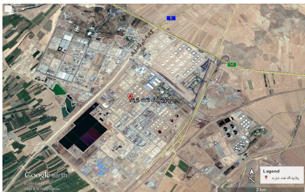
شکل ۲- عکس هوایی از پالایشگاه نفت شازند (منطقه مورد بررسی) Fig. 2- Aerial photo of Shazand oil refinery (study area)
