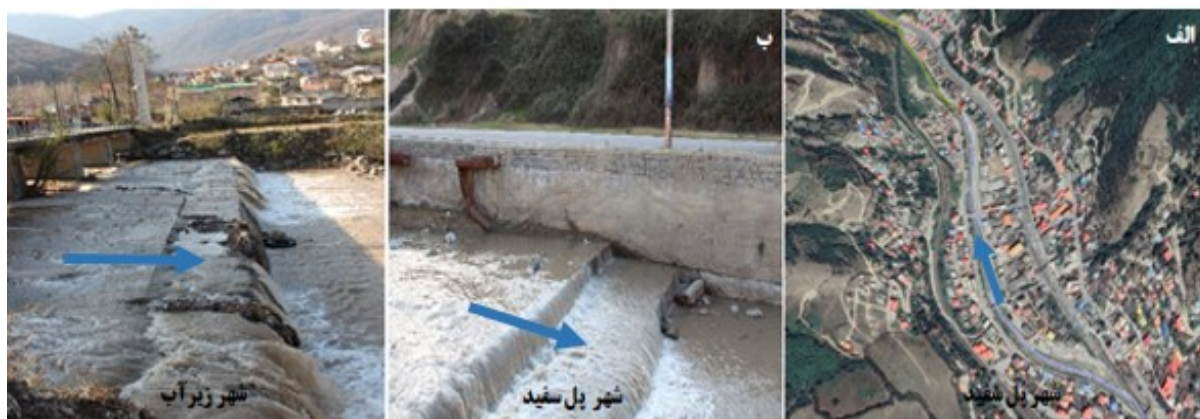
شکل ۶- نمونه‌ای از موانع پیوستگی در بازه‌های مختلف رودخانه (الف) نمای از بالای موانع پیوستگی شهر پل سفید؛ (ب) سازه عرضی (سرریز) موجود در بازه ۸؛ (ج) سازه عرضی (سرریز) موجود در بازه ۱۳ رودخانه تالار
