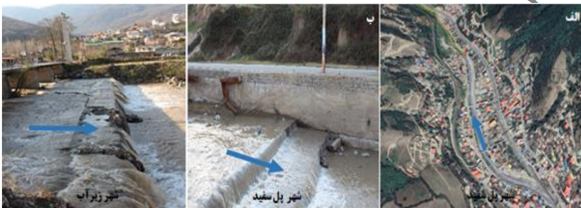
252 253 شکل ۶- نمونه‌ای از موانع پیوستگی در بازه‌های مختلف رودخانه (الف) نمای از بالای موانع پیوستگی شهر پل 254 سفید؛ (ب) سازه عرضی (سرریز) موجود در بازه ۸؛ (ج) سازه عرضی (سرریز) موجود در بازه ۱۳ رودخانه تالار. 255 Fig. 6- An example of connectivity barriers in different reaches of the river (a) View from above 256 the connectivity barriers of Pol Sefid city; b) Transverse structure (overflow) existing in reach 8; c) 257 Transverse structure (overflow) existing in the 13th reach of the Talar River. 258
